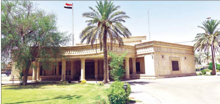
مبنى هيئة النزاهة
