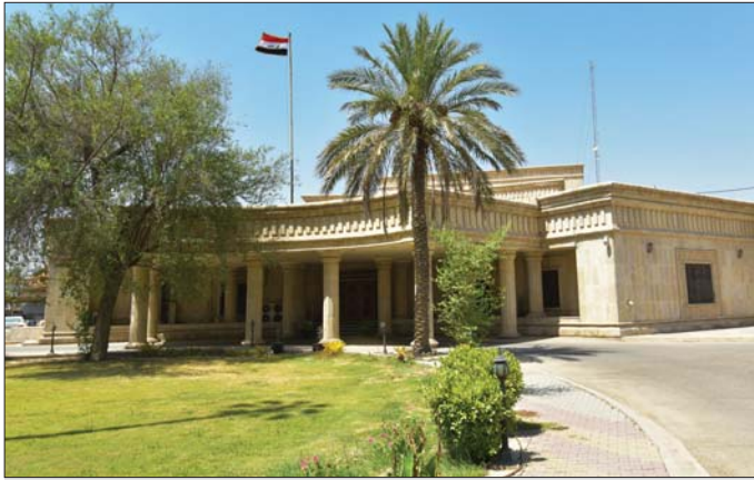
مبنى هيئة النزاهة
