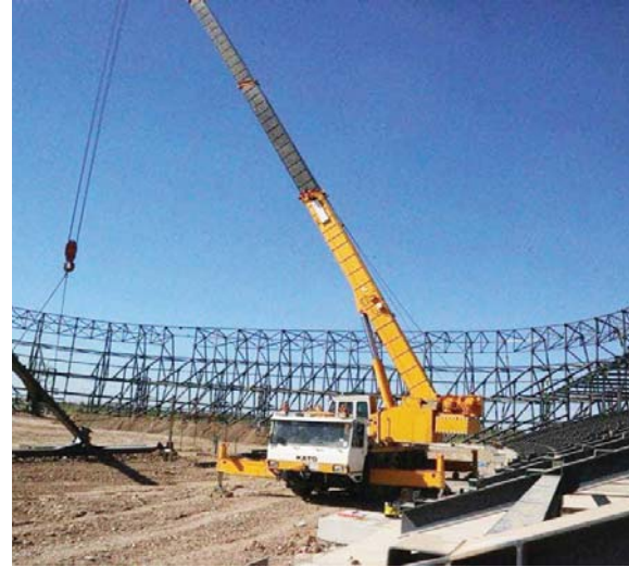
● إيشارة بإكمال الهيكل الحديدي للملعب
