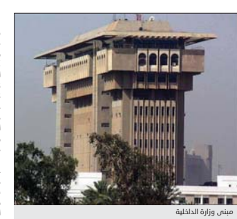
مبنى وزارة الداخلية
