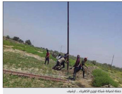
عملية صيانة شبكة توزيع الكهرباء... ارشيف
