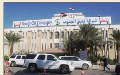
مبنى شركة النفط
