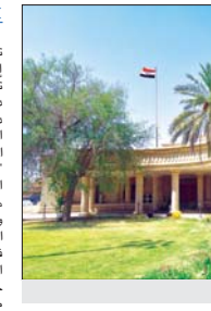
مبنى هيئة النزاهة
