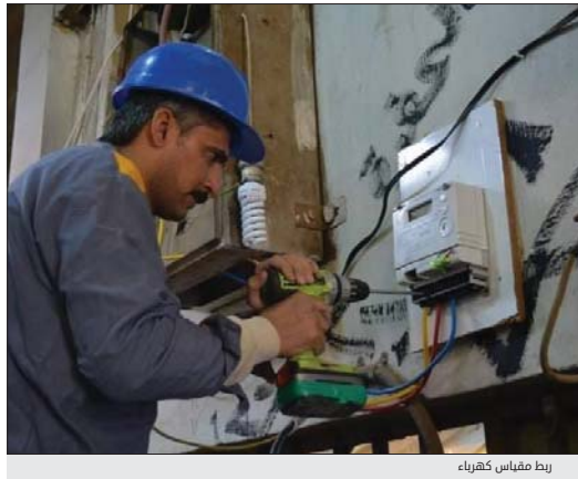
ربط مقياس كهرباء
