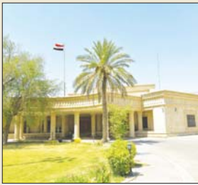
مبنى هيئة النزاهة
