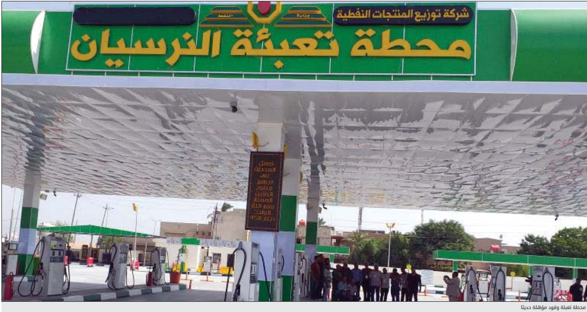
محطة تعبئة وقود مؤهلة حديثا
