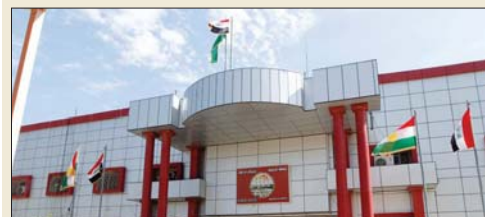
مبنى محافظة كركوك
