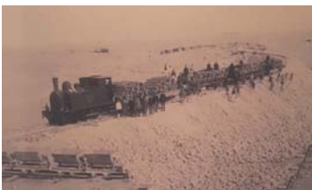
نقل مواد البناء على متن القطار لإكمال إنشاء السكة
