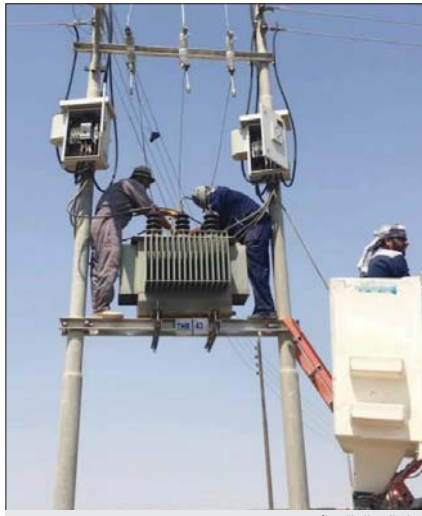
ميانة المحولات الكهربائية
