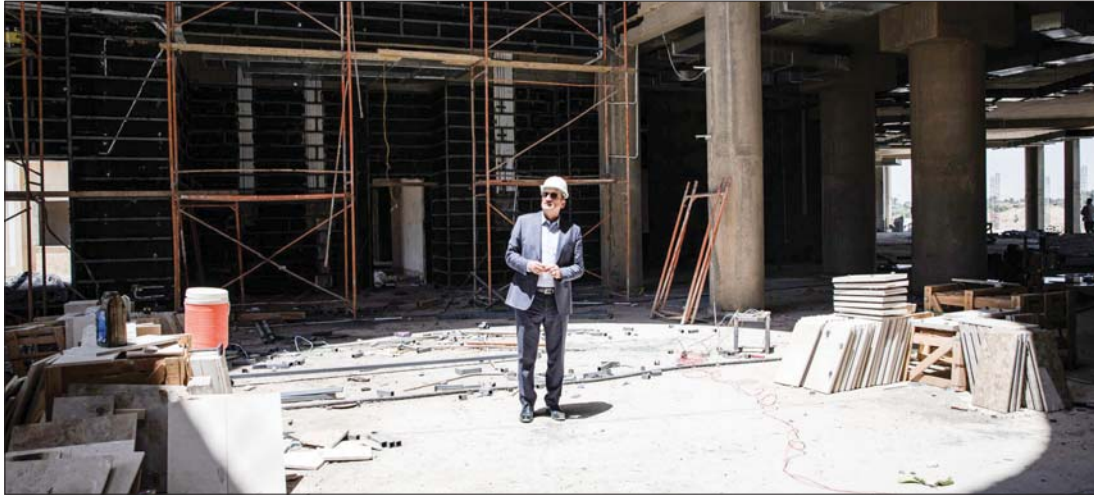
العمان متفقد أعمال البناء في أول شندق هدم
