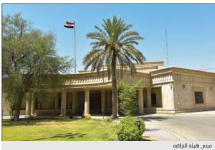
مبنى هيئة النزاهة
