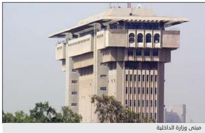
مبنى وزارة الداخلية
