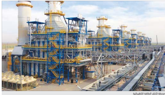
محطة لتأهيل الطاقة الكهربائية
