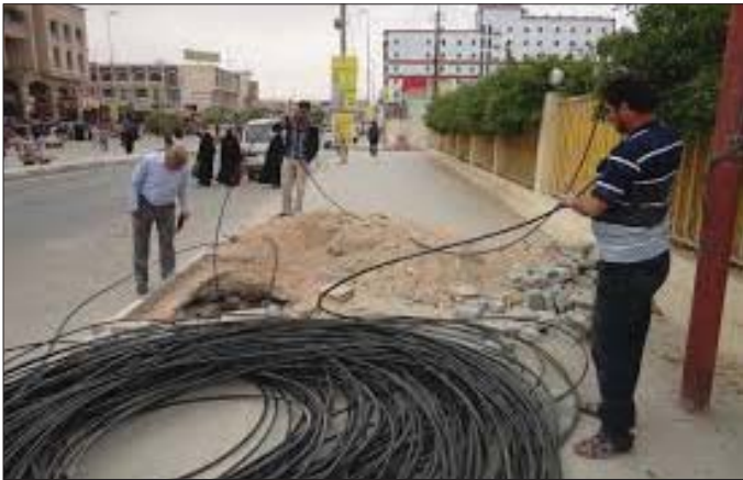
عملية مد الكيبل الضوئي الخاص بالإنترنت... أرشف
