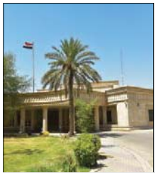
مبنى هيئة النزاهة
