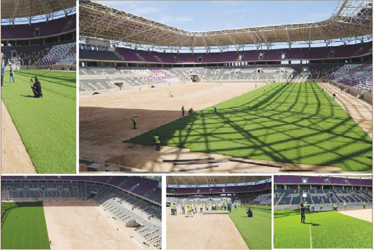
جانب من عملية فرش أرضية ملاعب الحبيبية بالثيل الطبيعي
