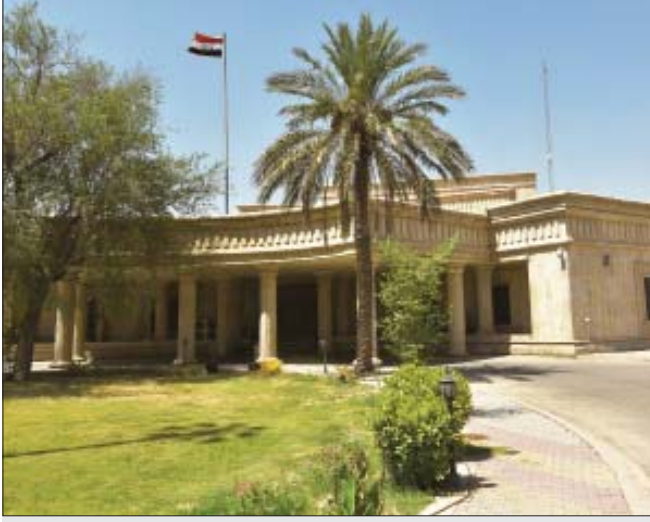
مبنى هيئة النزاهة
