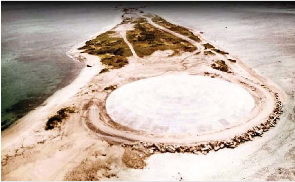
القبة الكونكريتية التي شيدت فوق فوهة طمر المواد المشعة، بعد التجارب النووية الأمريكية في إينيويتيك بجزر مارشال
