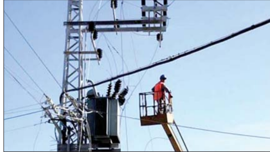
● تصليح خطوط الكهرباء
