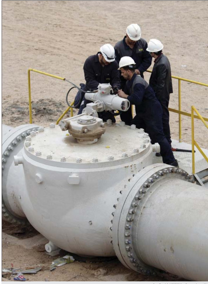
فنيون يفحصون انبوبا ناقل للنفط في البصرة
