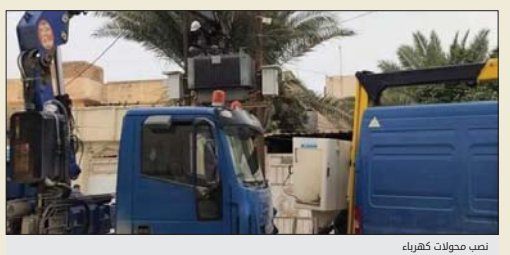
نصب محولات كهرباء
