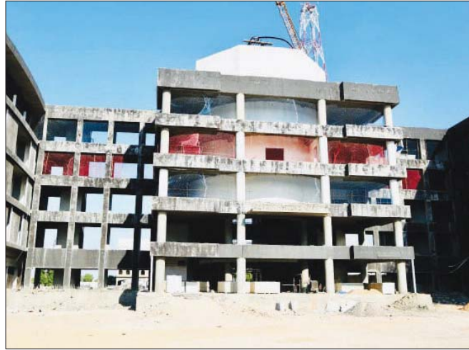
بنائة مجلس محافظة النجف قيد الانشاء
