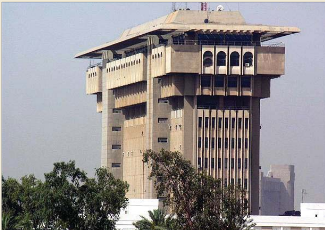
مبنى وزارة الداخلية
