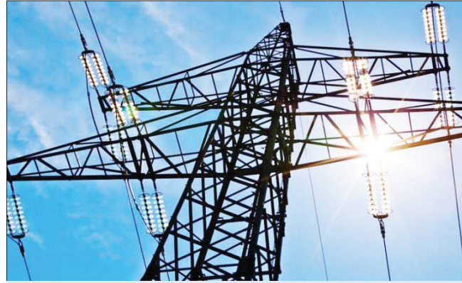
شكاكات نقل الكهرباء
