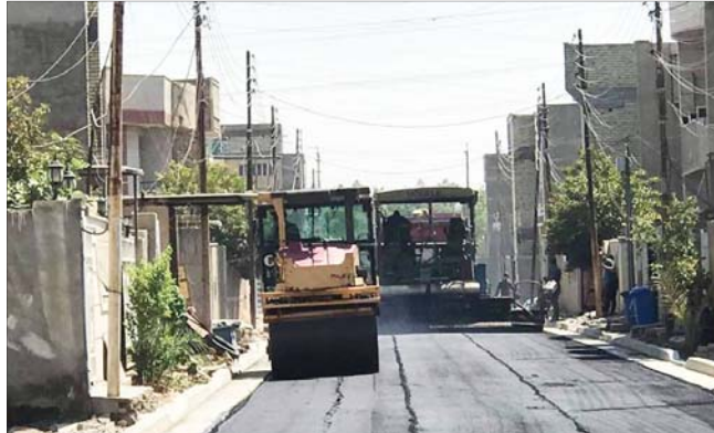
● أعمال اكساء شوارع داخلية
