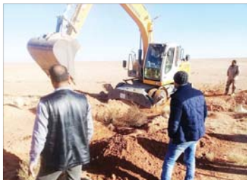
● عمليات اصلاح الكابل الضوئي
