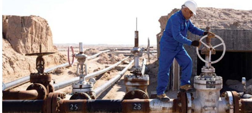
تأهيل خطوط نقل النفط الخام ضرورة ملحة
