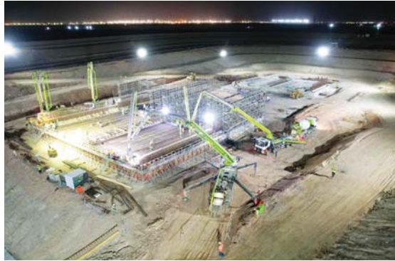
● عمل متواصل في مشروع «النفق المغمور»
