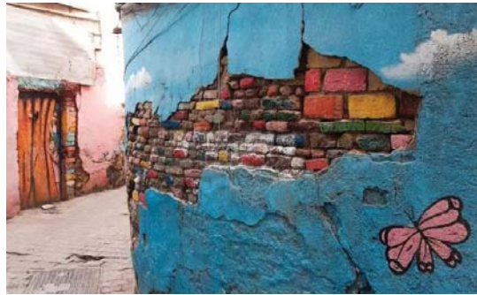
• بناء وترميم الدور والمنزل والمخارص
