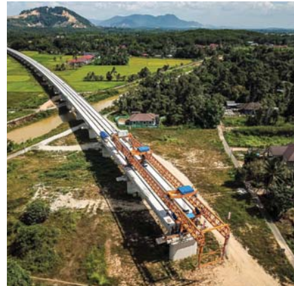
● جسر الطرق ضمن مشروع الحزام
