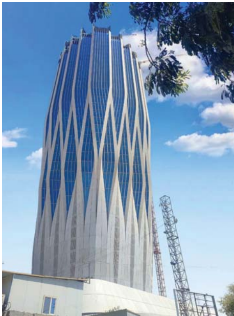
قرب إنجاز التحفة المعمارية الجديدة مبنى البنك المركزي العراقي
