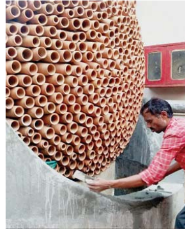
• يعتمد تصميم «خلية النحل» لشركة «كول أنت» على مبادئ التبريد بالتبخير والتبوية الطبيعية
