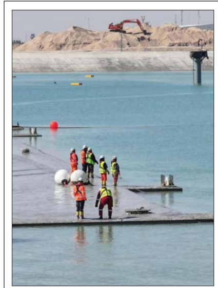
● تنفيذ عمليات نقل القطعة الأولى لمسار النفق المغمور تحت قناة حور الزبير
