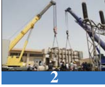
وسائل مطمئنة للمواطنين بشأن الكهرباء
