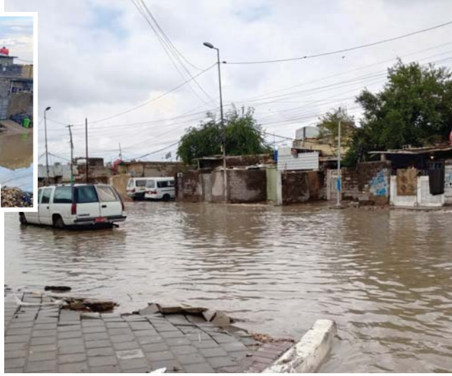
● مفتح المجاري ودخول مياه الأمطار للمنزل بسبب مشكلات بئرية خطيرة وخسائر مادية
